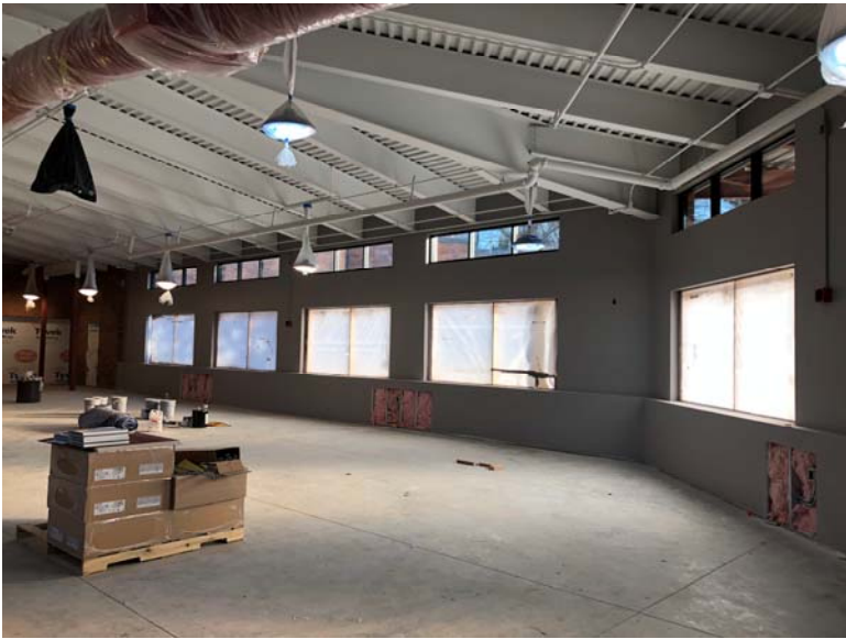
Commons west wall
