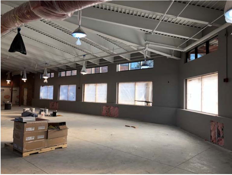
Commons west wall
