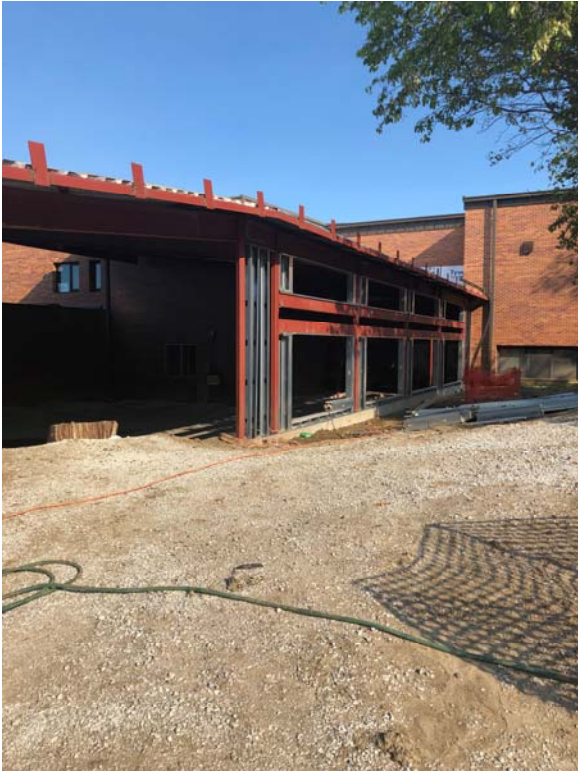
Commons structural steel erected
