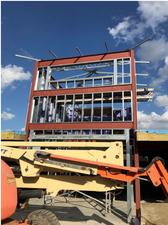
Commons entry tower
